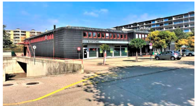
Gland, Rue des Tuillières 1 (VD)
